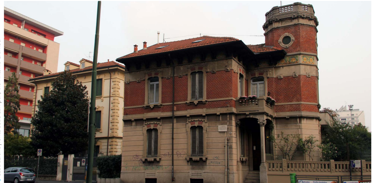
↓ Costruzione fronte sede Campari, Via Antonio Gramsci
